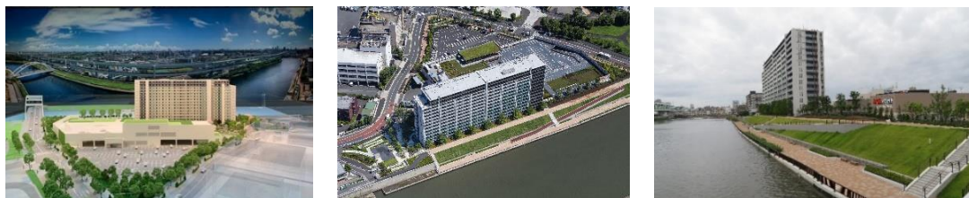
豊島四丁目模型／豊島四丁目開発の竣工写真／墨田川のスーパー堤防
