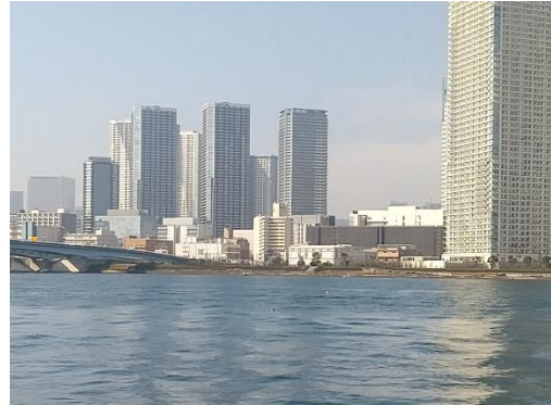
晴海3棟の近景と晴海運河からの遠景
