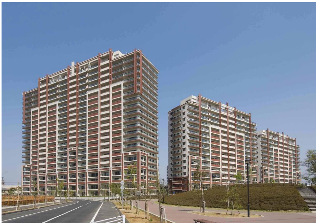
「おたかの森プロジェクト」竣工時の全景
