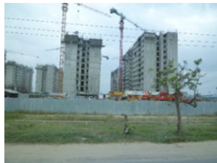
ヤンゴン市ダゴンセイカンで建設中の高層集合住宅（2014）
